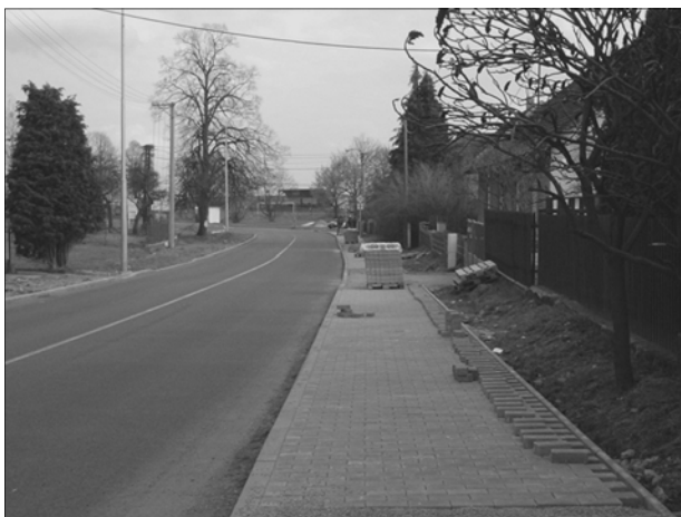
Započaté práce na chodníku směrem od Blatné foto -mr-
