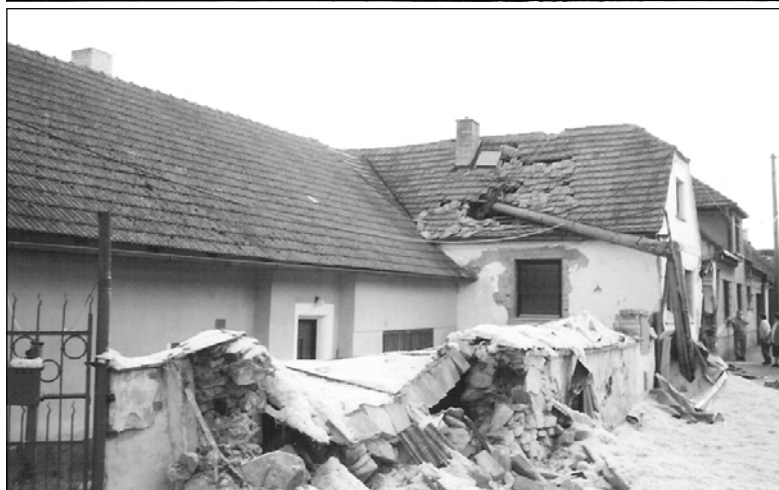
Na snímcích shora nehoda kamionu 18.4. 2008, na snímku dole poškozený dům č. p. 260 po nehodě kamionu v roce 2004.
