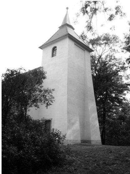
Hlavní věž kostela s novou fasádou
