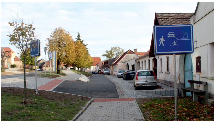
Nová silnice a chodníky ve spodní části Jánského náměstí
