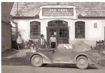
Strojírenská dílna Jana Cába, dříve Antonína Spěšného, na snímku z 23. 8. 1946 (fotoarchiv města Kasejovice).
